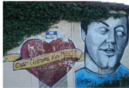
À Opio, sur un transformateur EDF, un graffiti qui par la suite a été recouvert de peinture grise
